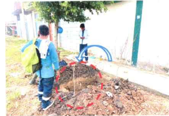
Foto: Esquinero n° 35B2 Intersección con JR. EL TRIUNFO CON JR. MARIANO CONZA se encontró un accesorio "TEE" de 110mmX110mm PVC.
