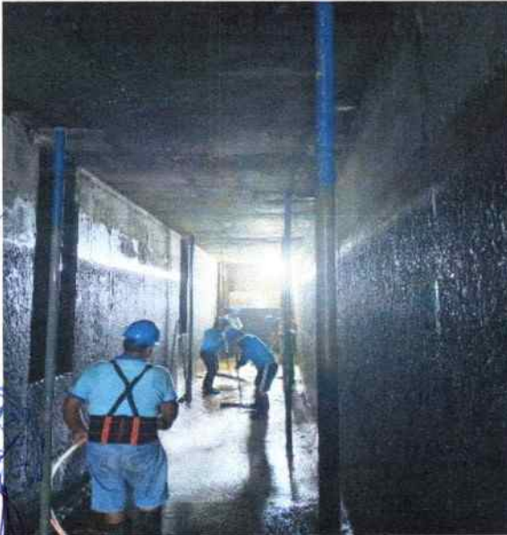
IMAGEN N° 16 LAVADO Y ENJUAGUE DEL PISO DEL CANAL DE AGUA DECANTADA (CAD), 13/12/2024
