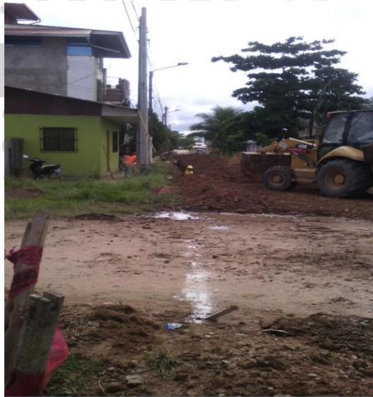
**Vista Fotográfica N° 01 (10/05/2017):** Se viene realizando el trazo y replanteo del eje de tubería PVC 110 mm. Esta actividad se ubica en la calle cuatro.
