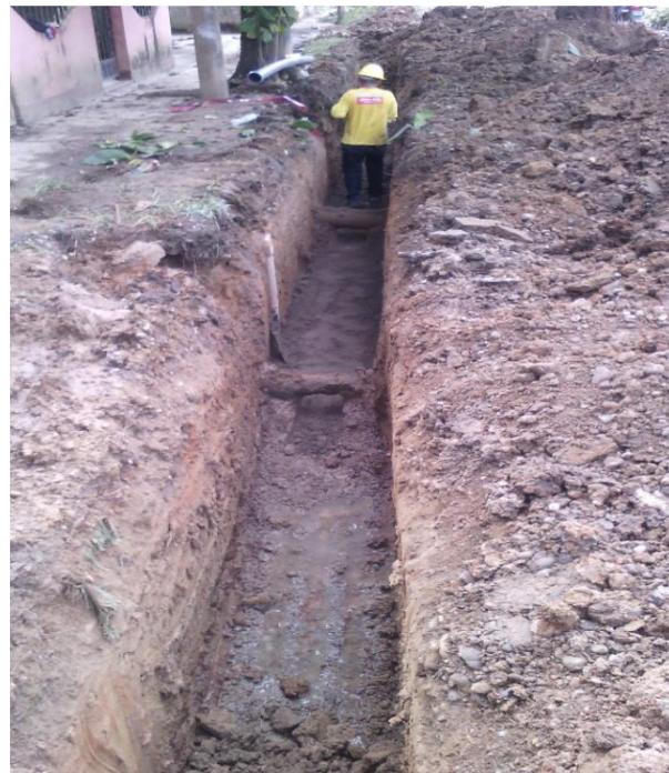
**Vista Fotográfica N° 03 (17/05/2017):** Se viene realizando los trabajos de perfilado y colocado de cama de arena antes de colocar la tubería de PVC de 110 mm; esta actividad se realiza en el psje. Ocho.
