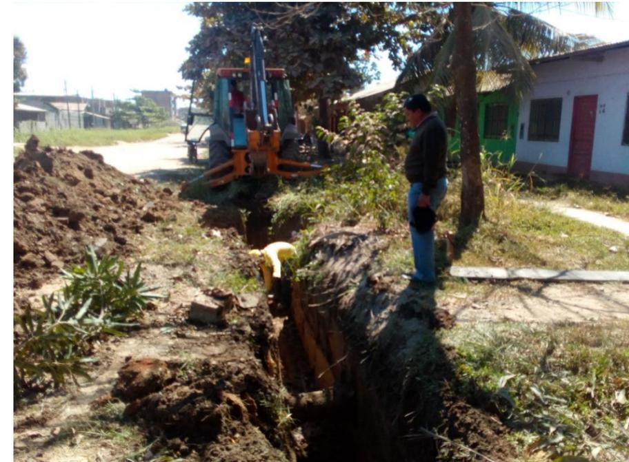
**Vista Fotográfica N° 01 (20/07/2017):** Se viene verificando por parte de la residencia de obra la instalación de las tuberías de PVC de 160 mm.
