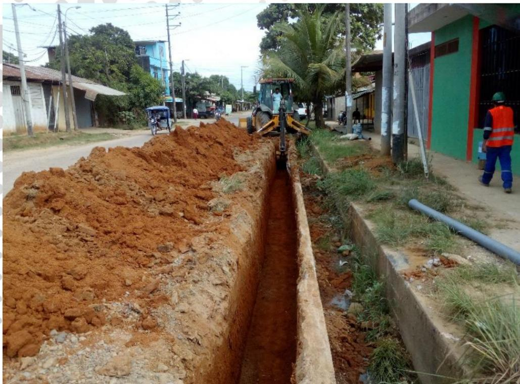
**Vista Fotográfica N° 01 (20/06/2017):** Se viene la excavación de zanja para la colocación de las tuberías de PVC de 110 MM en el Jr. Junín; esto pertenece al adicional de obra.
