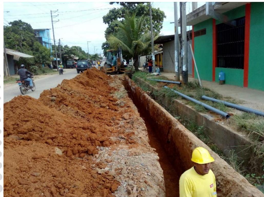
**Vista Fotográfica N° 02 (20/06/2017):** Se viene la colocación de las tuberías de PVC de 110 mm en el tramo excavado del Jr. Junín.
