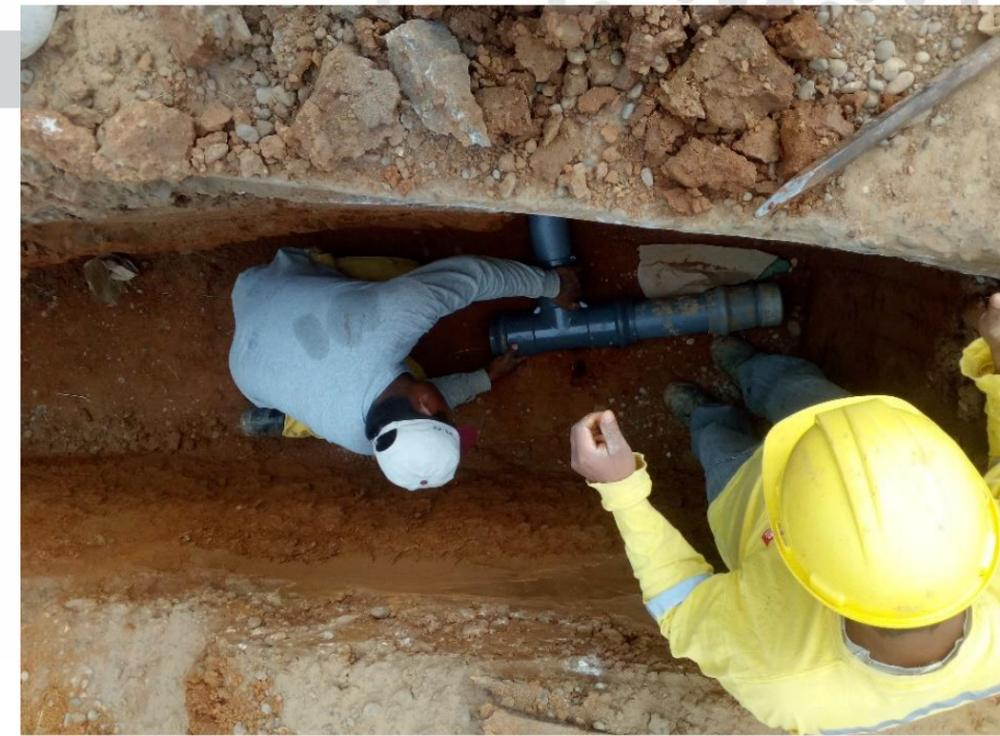
**Vista Fotográfica N° 03 (20/06/2017):** Se viene realizando la colocación de accesorios de PVC como es la tee de 110 mm en las esquinas de las manzanas.
