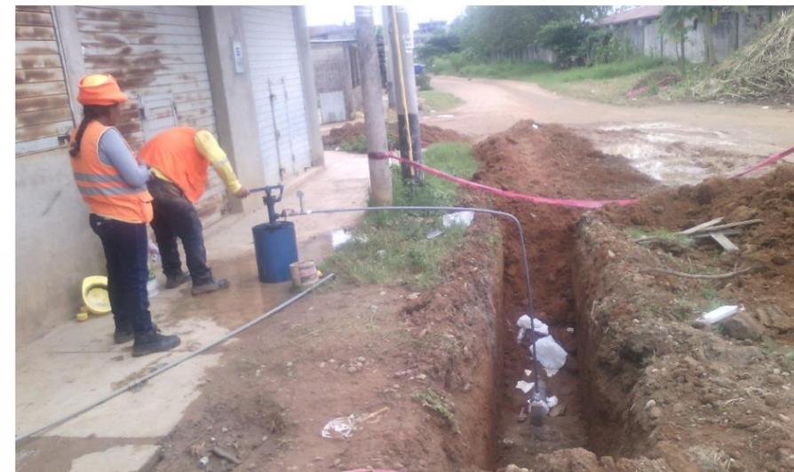
**Vista Fotográfica N° 06 (30/05/2017):** Se viene realizando la prueba hidráulica a zanja cerrada con solo vista de accesorios, el cual es para verificar fugas probables de la prueba. Esta actividad se viene realizando en la calle tres.
