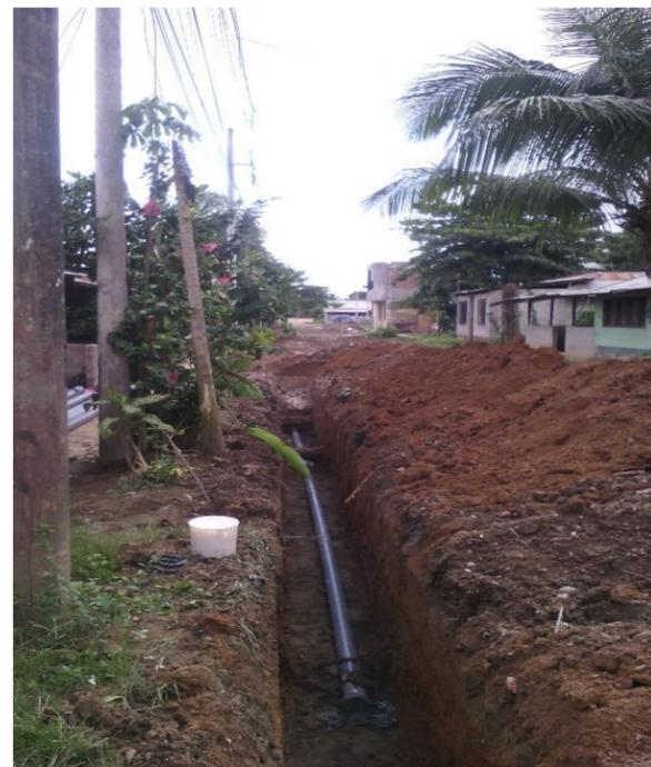
**Vista Fotográfica N° 04 (18/05/2017):** Se viene realizando los trabajos colocación de tuberías de PVC de 110 mm en toda la calle cuatro.
