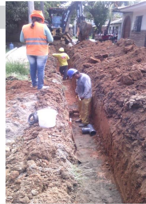
**Vista Fotográfica N° 05 (22/05/2017):** Se viene realizando los trabajos de instalación de accesorio de PVC Tee de 110 mm en las intersecciones; esta actividad se ha realizado entre el psje. Trece y la calle cuatro.
