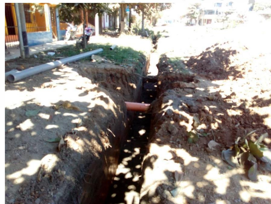
**Vista Fotográfica N° 04 (21/07/2017):** Se viene reparando las tuberías de PVC de 160 mm de desagüe, por motivo de las excavaciones que se vienen realizando.
