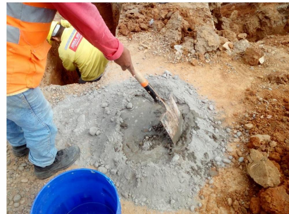
**Vista Fotográfica N° 04 (20/06/2017):** Se viene realizando el dado de concreto para la fijación de los accesorios de PVC, esto permite proteger a los accesorios por la inmensa fuerza de presión del agua potable.
