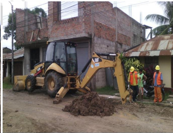
**Vista Fotográfica N° 02 (12/05/2017):** Se viene realizando la excavación de zanja con maquinaria pesada. Esta actividad se ubica en la calle tres.
