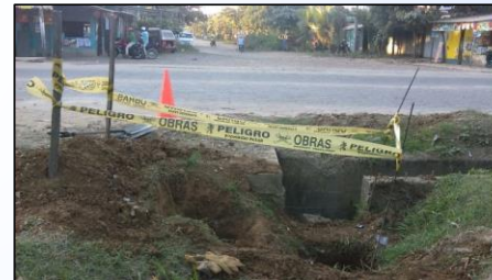
Cinta de seguridad en perímetro de poza, para evitar cualquier accidente producto de la excavación.
