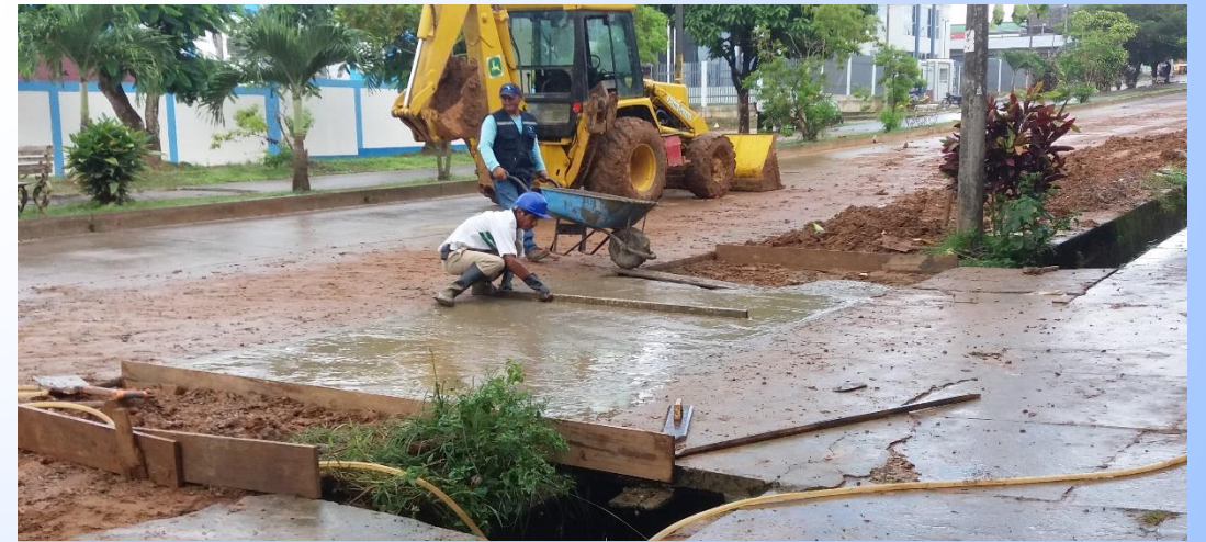
Reposición de veredas y pontones peatonales accesos domiciliarios y limpieza de la Av. Fitzcarrald para tránsito de vehículo.
