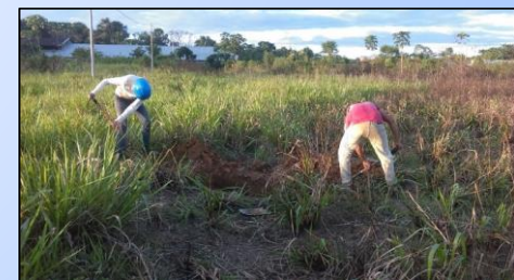
Realizando el relleno y compactado de zanjas, luego de la ubicación del accesorio.
