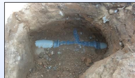
Tee PVC Ø 110 mm. encontrada en el Jr. Jorge Chávez con calle Las Begonias
