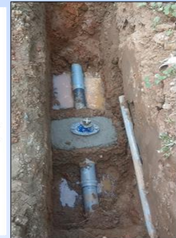
Realizando el catastro de una válvula de hierro dúctil de Ø 110 mm., en la obra "Ampliación de Red de Agua secundaria en la Av. Aeropuerto, entre la Av. Elmer Faucett y la Av. La Joya"
