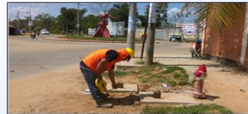
Realizando la ubicación de una válvula de control de un hidrante, en la Av. Aeropuerto con Av La Joya.
