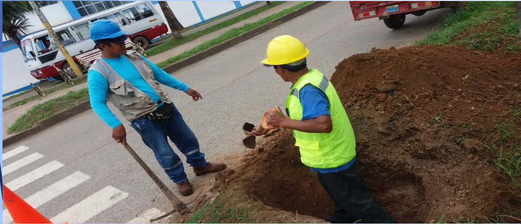
Calicata para verificación de Red de Desagüe Intersección Jr. Puno con Av. Fitzcarrald.
