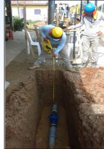
Realizando el catastro de una válvula de hierro dúctil de Ø 110 mm., en la obra "Ampliación de Red de Agua secundaria en la Av. Aeropuerto, entre la Av. Elmer Faucett y la Av. La Joya"
