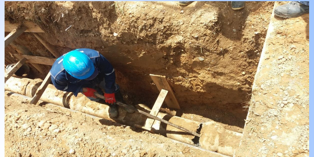
Eliminación de tubería concreto simple normalizado (AC).
