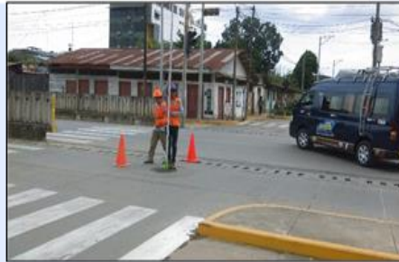
Tomando lectura a la tapa de los buzones de alcantarillado.
