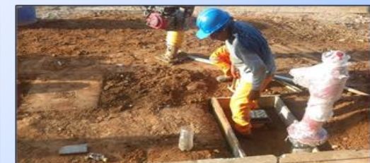
Viendo el trabajo de instalación de caja de válvula control de un hidrante, en la Av. Aeropuerto con Jr. Teniente Acevedo.
