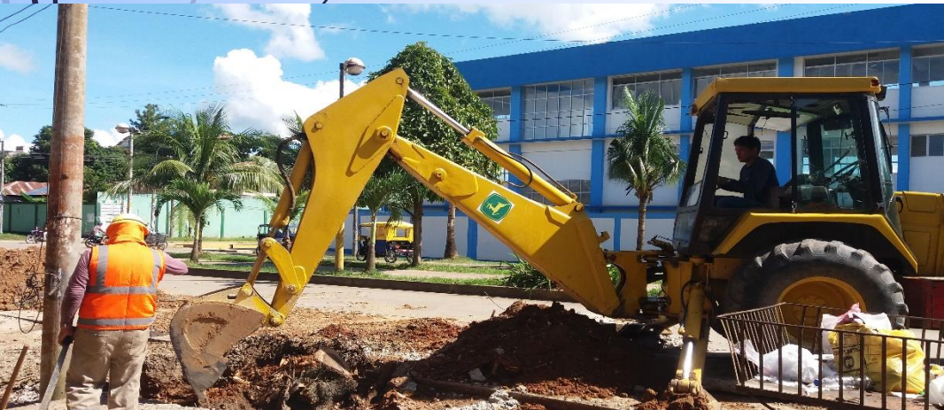
Excavación de zanja con retroexcavadora para instalación de tubería PVC de Desagüe.
