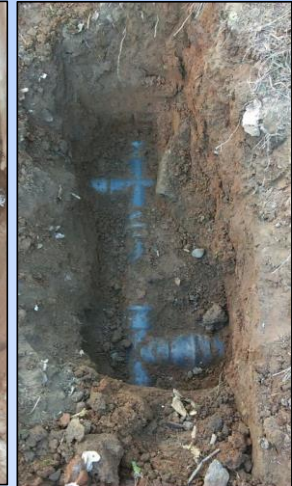
1) Cruz + Tapón PVC Ø 110 mm. 2) Tee PVC Ø 110 mm.
