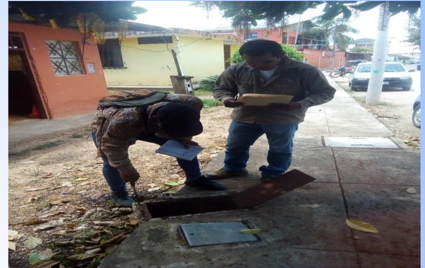
INSPECCIONES POR ACTIVACION DE DESAGUES EN USO
